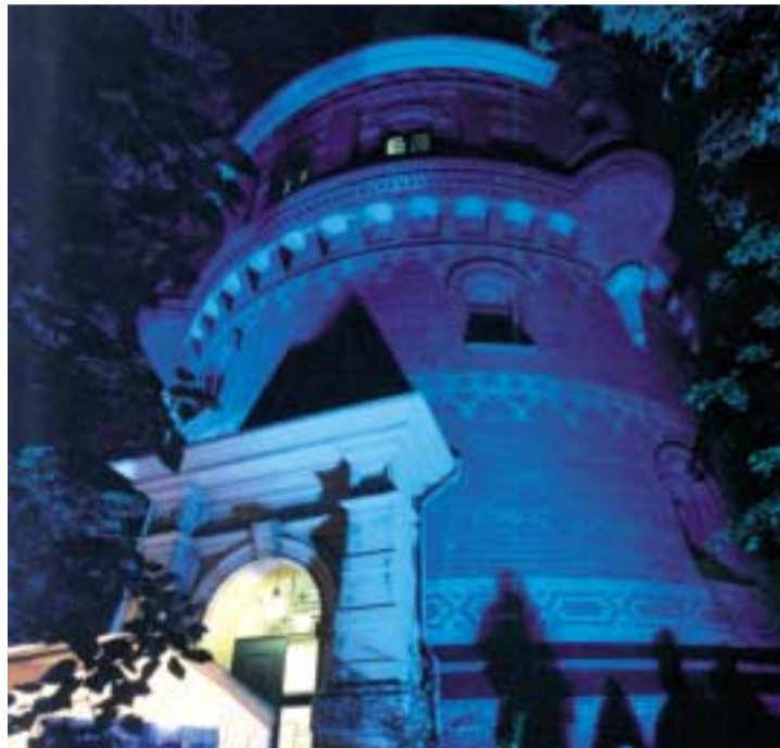
Der alte Wasserturm des Instituts für Meteorologie lockte im vergangenen Jahr die Besucher der ersten Langen Nacht in Scharen an.
