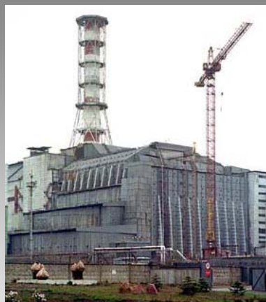
Schutzhülle („Sarkophag“) aus Stahlbeton nach 7-monatiger Bauzeit fertiggestellt
