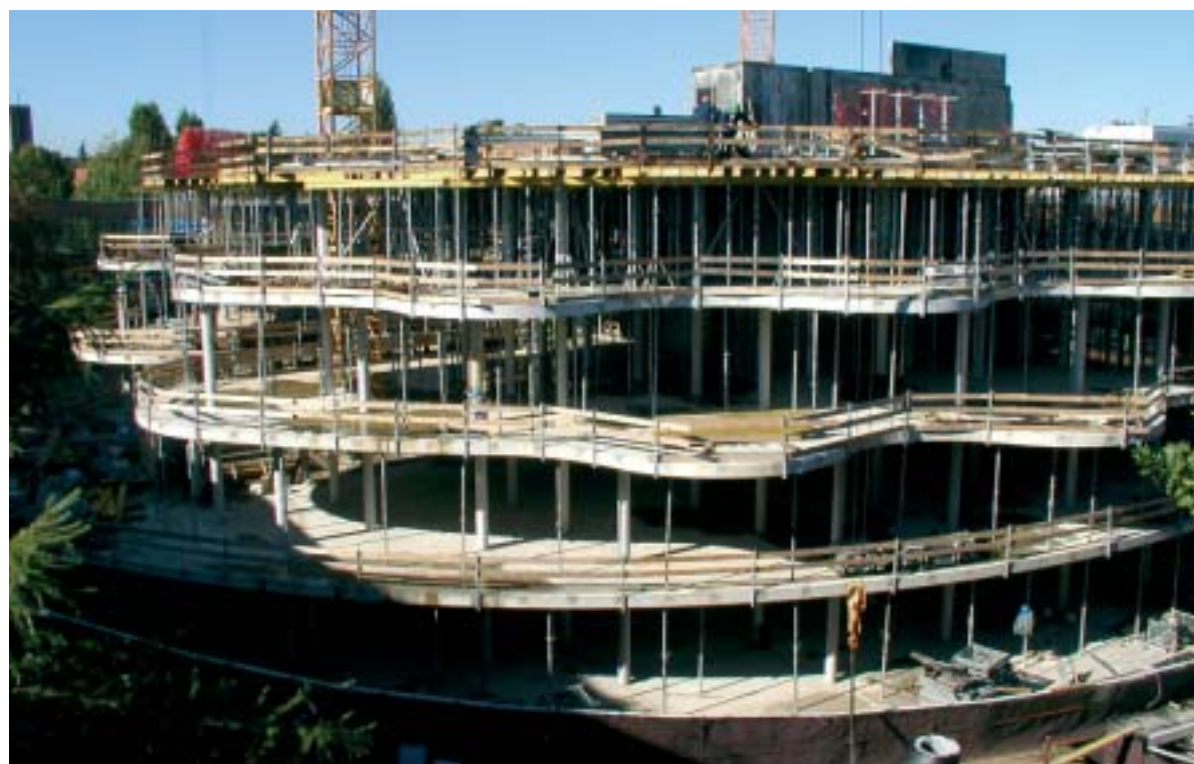
Schon im Rohbau sind die wellenförmig gestalteten Geschossränder deutlich zu erkennen, die später berührungslos an die weit gespannte Kuppel angrenzen werden.
